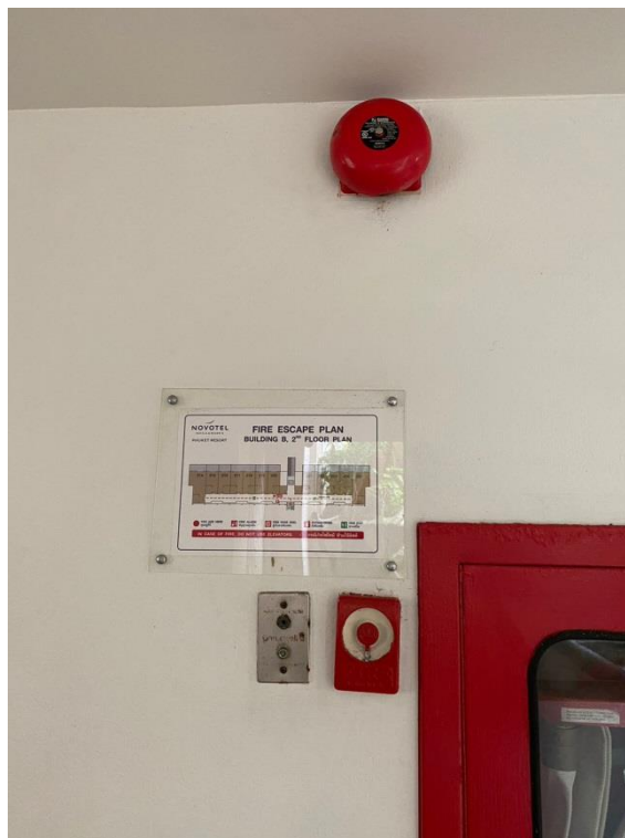
ภาพที่ 4 แสดงสัญญาณเตือนภัยด้วยมือ / Alarm bell
